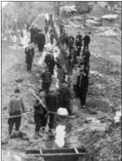
Изграждане на чешмата в с. Горна Бешовица
